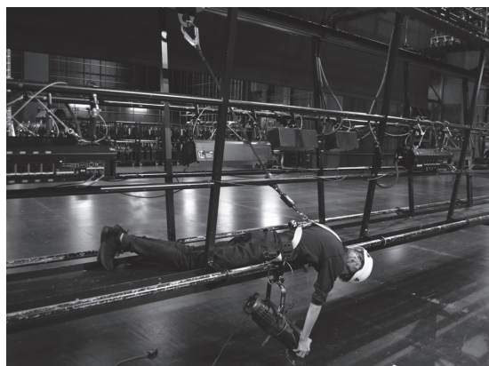
ハーネスを着用した作業例
