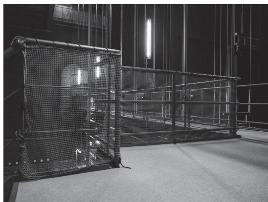
落下防止ネット設置例
