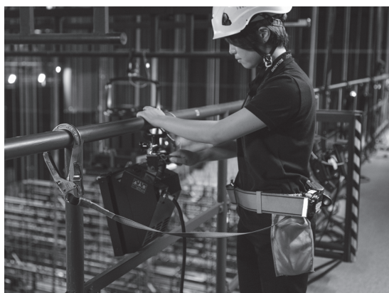
安全帯を着用した作業例
