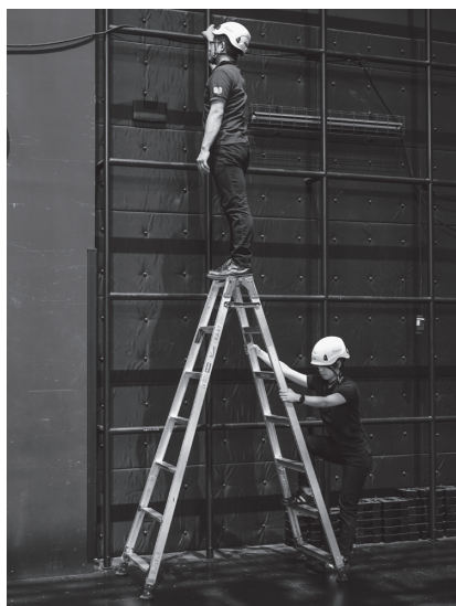
天板に立っての作業
