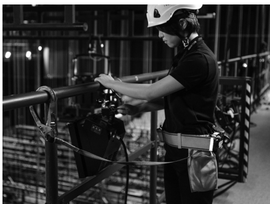
安全帯を着用した作業例
