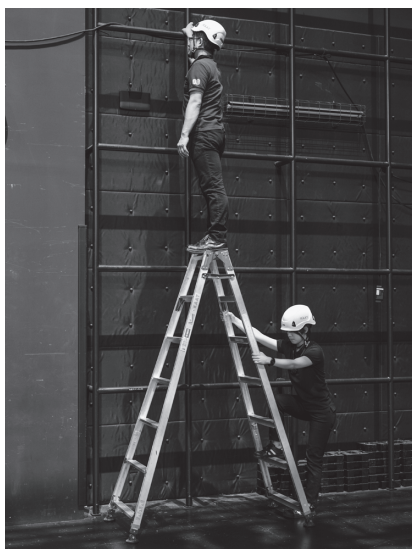
天板に立っての作業
