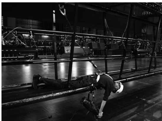
ハーネスを着用した作業例
