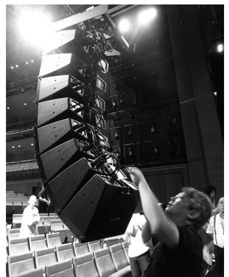
プロセニアムスピーカーを下ろし、ラインアレイを間近に見る
